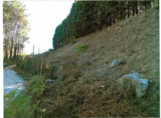
Foto 02_Vista general talud existente.
