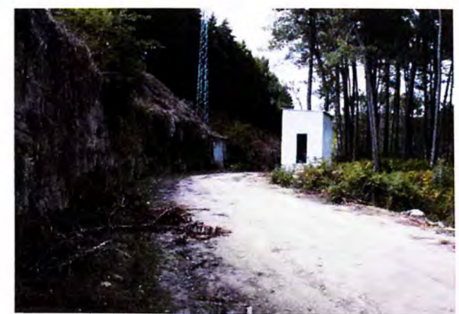
Fotografía 01: Vista general muro contención existente.
