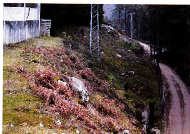
Fotografía 01: Vista general muro contención existente.
