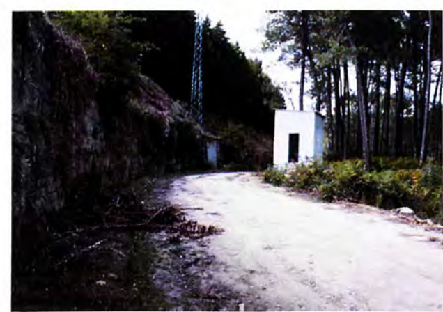
Fotografía 01: Vista general muro contención existente.
